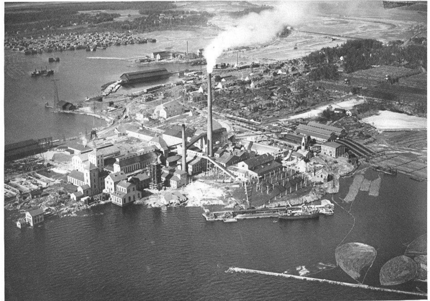
Skoghallsverken vid Klarälvens utlopp i Vänern är en mönsteranläggning, där träindustriens snart sagt alla grenar, elektriskt sågverk, sulfidfabrik, sulfatfabrik, sulfitspritfabrik, elektrokemisk fabrik etc., finnas sammanförda, och där stora hamnanläggningar möjliggör direkt utförsel med oceangående fartyg (efter Trollhätte kanals senaste utvidgning). Foto: Aero-Materiel (1049).
